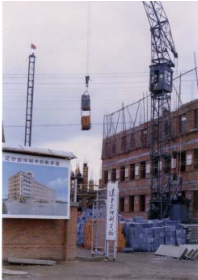
圖 24-3 遼寧省印刷學校建設中的教學樓
